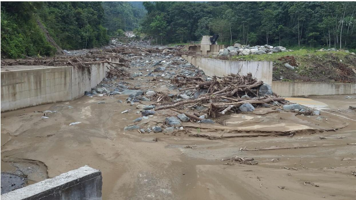
**Figura 4. Bloqueo de la estructura de captación de agua de Hidrotambo por acumulación de escombros. Fotografía facilitada por el Equipo de Proyecto Dulcepamba después de la inundación de marzo de 2015.**
